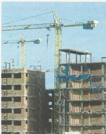
Viviendas en construcción.
